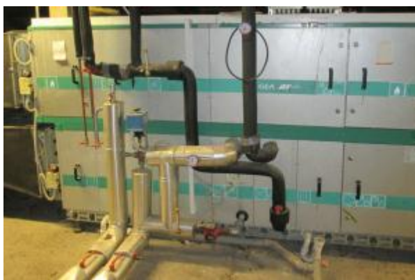
Slika 29: Prezračevalna naprava z možnostjo ogrevanja in hlajenja na podstrešju
