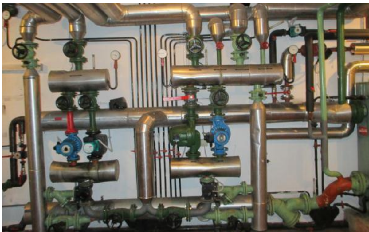
Slika 5: Toplotna podpostaja
