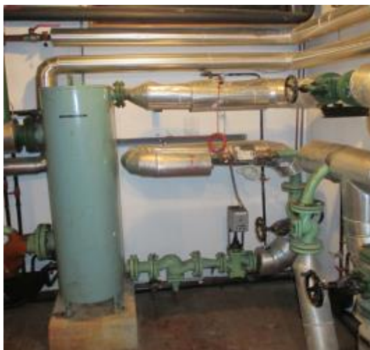
Slika 6: Toplotna podpostaja Vir: lastni vir.
