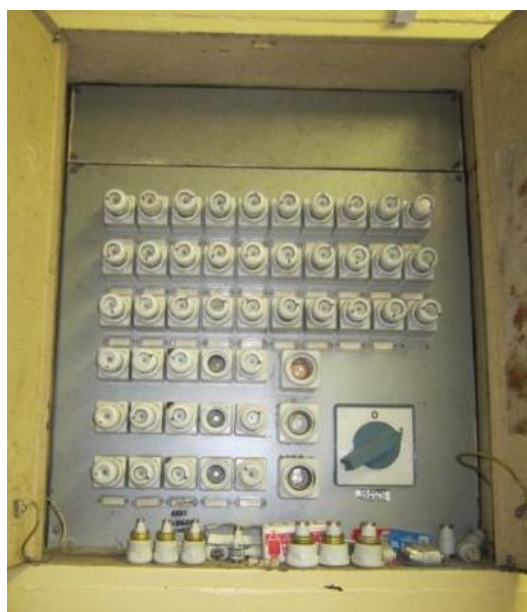
Slika 17: Posnetek etažnega razdelilca (stari del) Vir: lastni vir.
