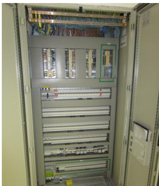
Slika 16: Posnetek etažnega razdelilca (novi del) Vir: lastni vir.
