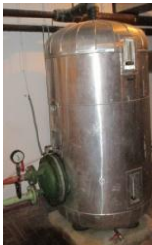
Slika 7: Bojler za TSV 800 litrov Vir: lastni vir.
