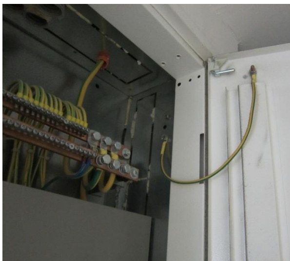
Slika 25: Posnetek galvanskih povezav
