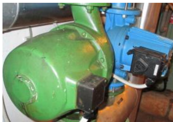
Slika 9: Obtočne črpalke Vir: lastni vir.
