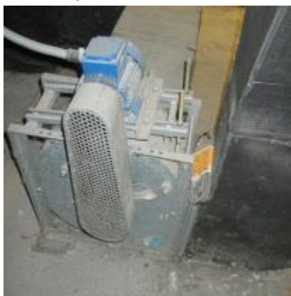
Slika 12: Ventilator potreben zamenjave Vir: lastni vir.
