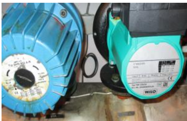
Slika 8: Obtočne črpalke Vir: lastni vir.
