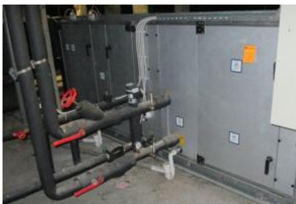
Slika 29: Prezračevalna naprava z možnostjo ogrevanja in hlajenja na podstrešju
