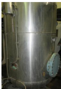
Slika 14: Bojler za TSV 1500 litrov Vir: lastni vir.
