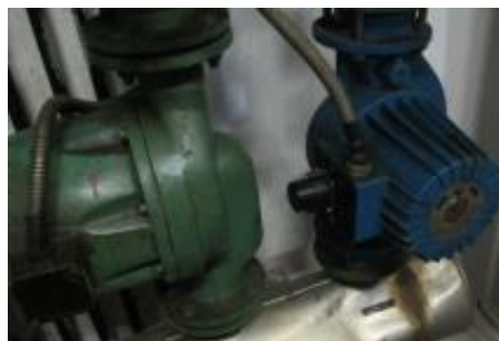
Slika 15: Obtočne črpalke Vir: lastni vir.
