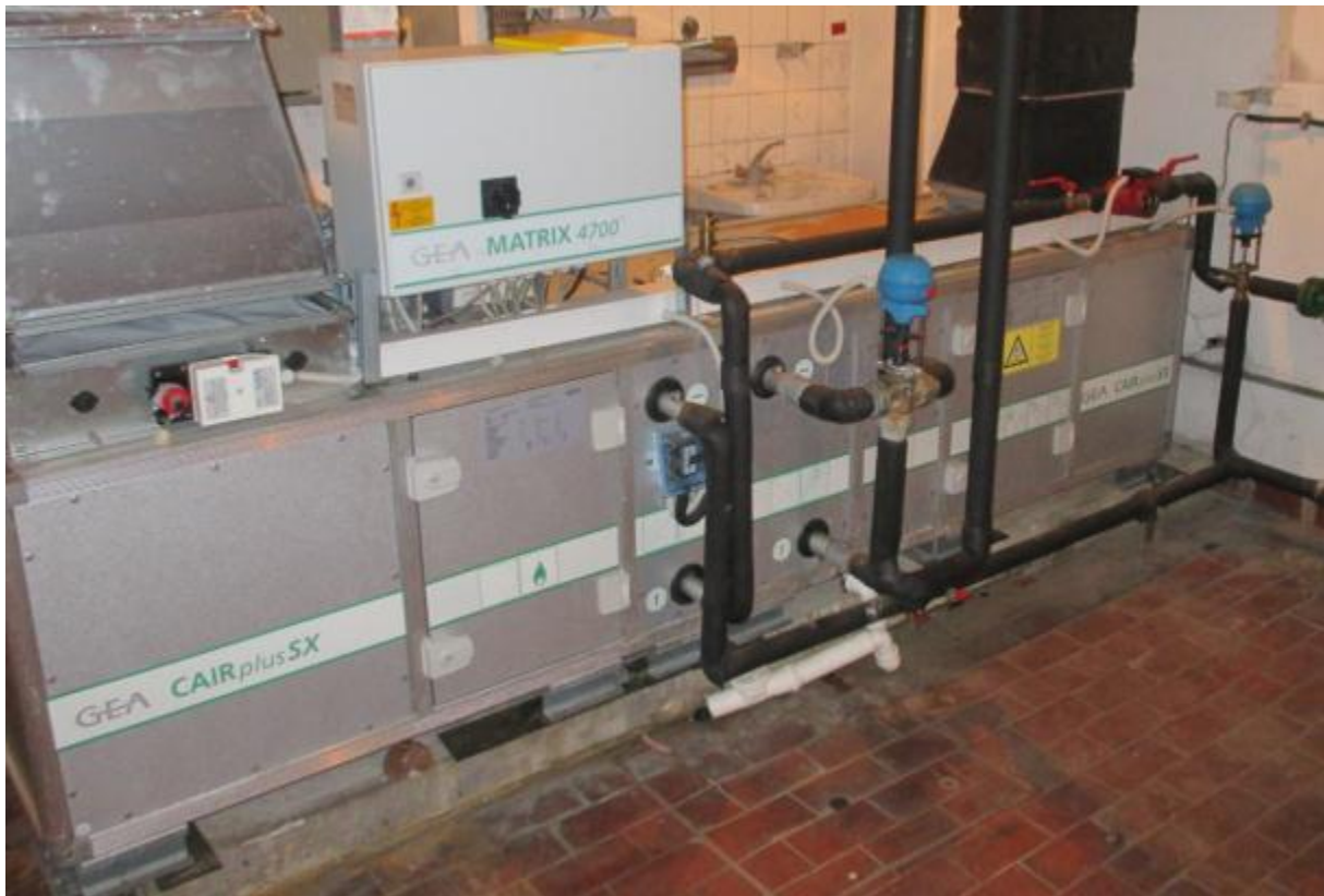
Slika 27: Prezračevalna naprava z možnostjo ogrevanja in hlajenja v toplotni postaji 1 Vir: lastni vir.
