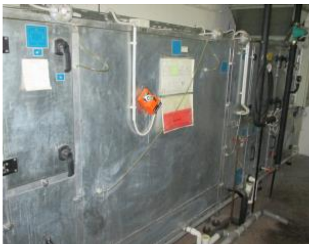
Slika 28: Prezračevalna naprava z možnostjo ogrevanja in hlajenja v toplotni postaji 2 Vir: lastni vir.
