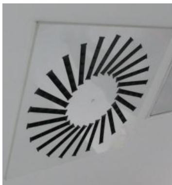
Slika 32: Distribucijski elementi za prezračevanje
