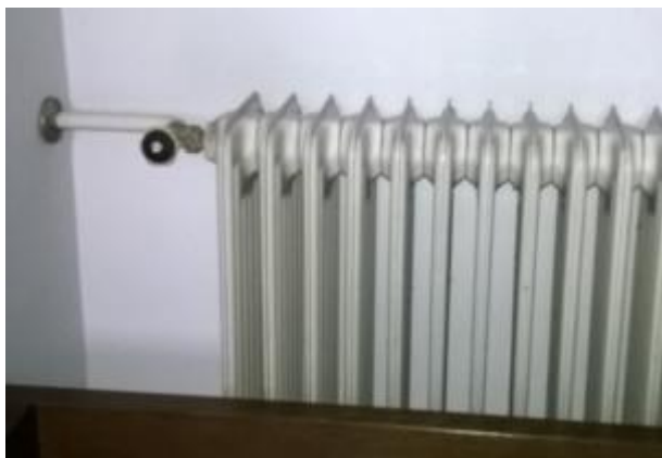
Slika 11: Členkasti radiatorji brez termostatskih ventilov Vir: lastni vir.
